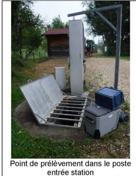
Point de prélèvement dans le poste entrée station
